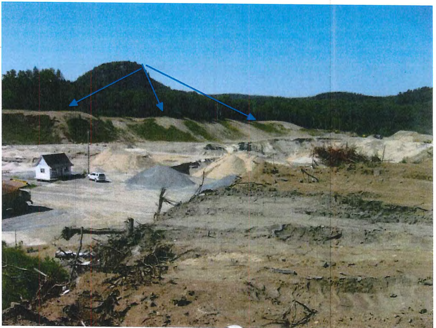
IMG_6808.JPG 12) La végétation est en croissance sur la portion du lot 9A maintenant restauré. La période de sécheresse des dernières semaines ne facilite pas l'enracinement et la croissance des végétaux. Les pentes sont clairsemées à certains endroits.
