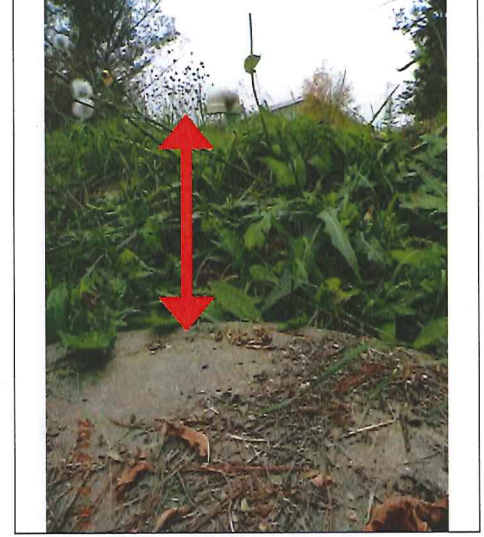
DSC02736 (Small).JPG Photo 18. Couverture de béton sous le niveau de la surface du sol (environ 30 cm)
