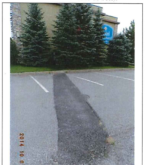
DSC02723 (Small).JPG Photo 9. «Couloir d'asphalte»
