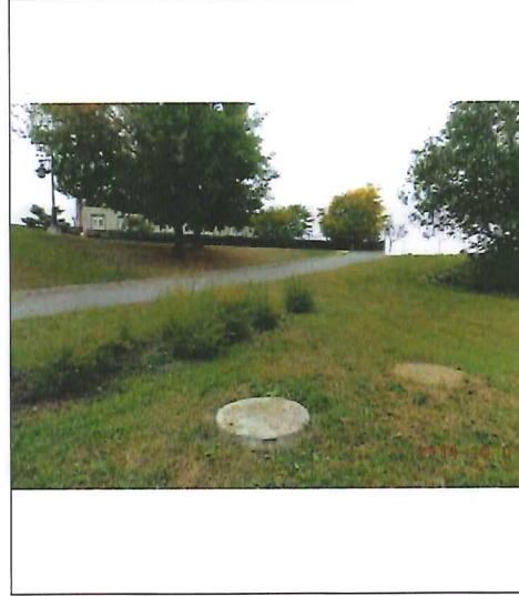
DSC02730 (Small).JPG Photo 17. Installations de traitement des eaux usées
