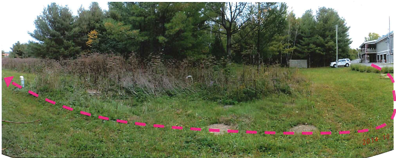
Figure 6 - Installations septiques de l'hôtel et du restaurant Saint-Bernard (flèche et pointillés roses = cheminement des eaux usées)
