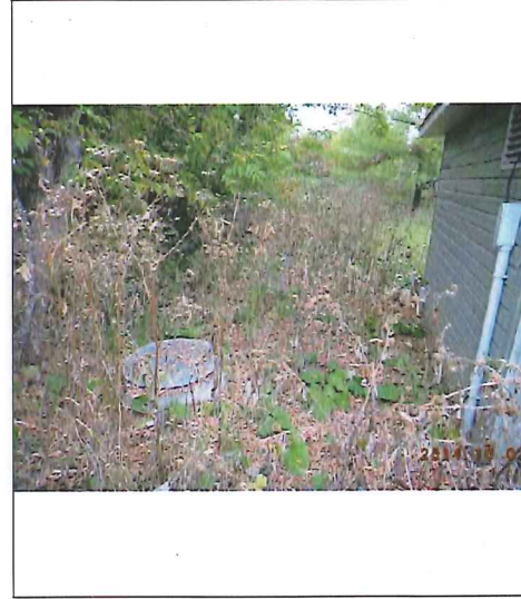
DSC02738 (Small).JPG Photo 20. Cabanon et couvercle de béton
