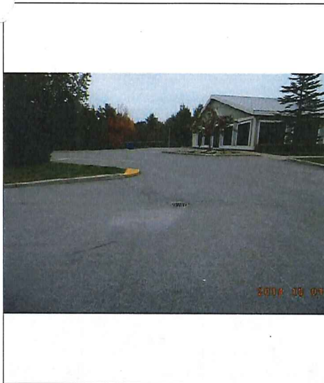
DSC02745 (Small).JPG Photo 2. Puisard stationnement centre d'accueil
