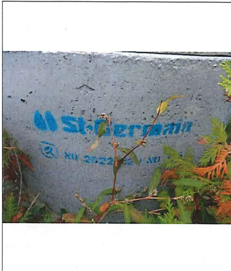
DSC02718 (Small).JPG Photo 5. Identification sur dalle de béton
