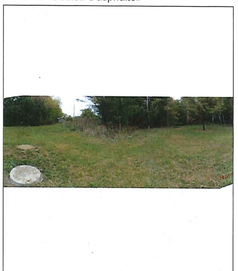
Stitched_001.JPG Photo 12. Installations de traitement des eaux usées
