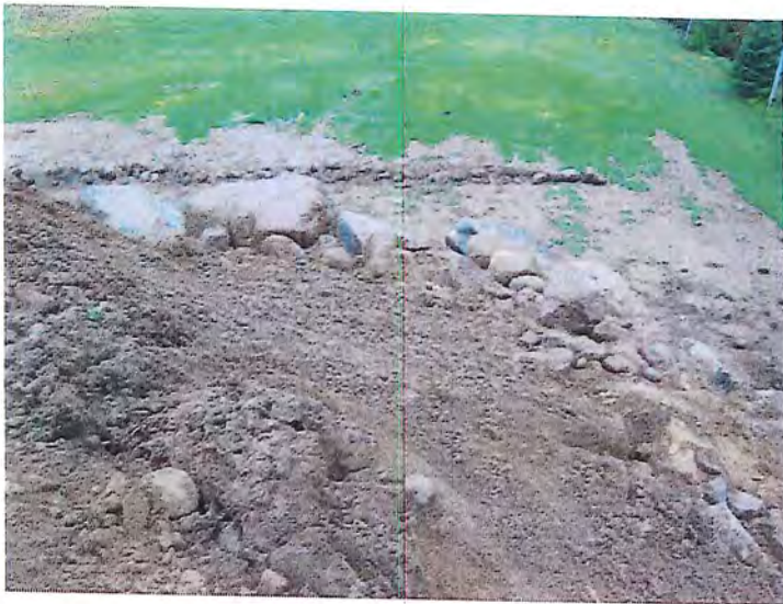
IMG_3862.JPG ③ Vue du champ d'épuration, à partir du remblai.
