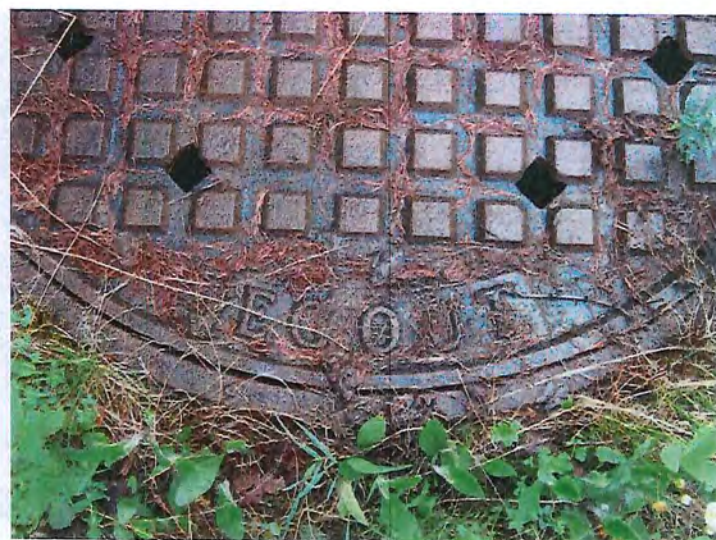
IMG_3869.JPG 8 autre vue du couvercle du regard à chute.
