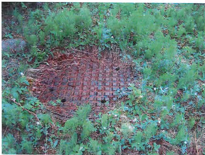
IMG_3868.JPG 7 Couvercle pour le regard à chute.
