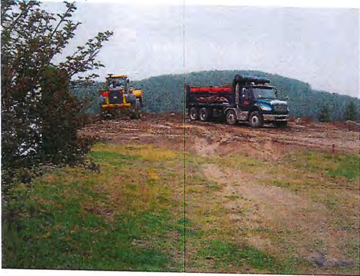
IMG_3860.JPG ① Remblaiement au golf, en face du champ d'épuration.
