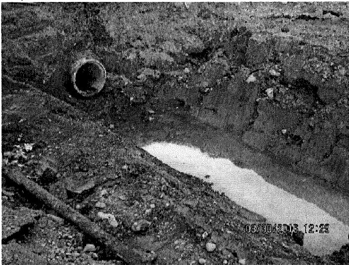
IMG_4494.JPG : État de l'excavation avant le début des travaux de récupération. Extrémité Ouest
