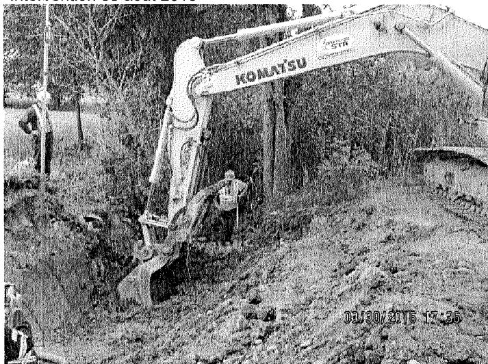
IMG_4500.JPG : excavation des sols contaminés
