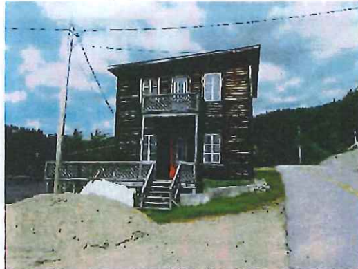
photo 10 sable en entreposage sur le terrain
