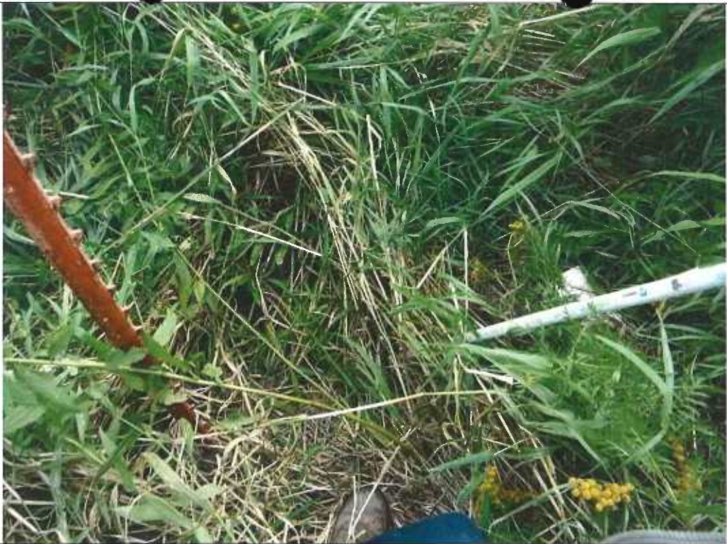
Photo 28. Sortie potentielle suite à l'installation septique déjà en place (tuyau blanc à droite)
