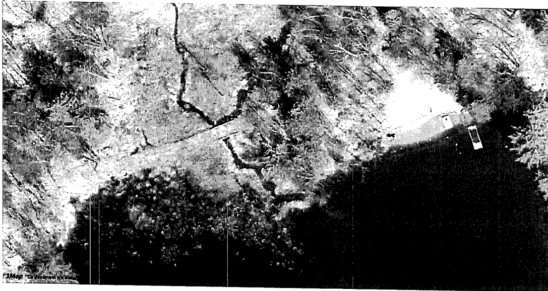
Photo aérienne avril 2011 – Chemin d'accès dans le marécage + pont. Plage existante.
