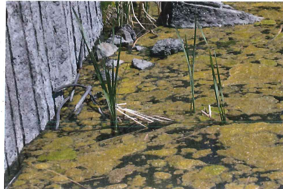
Identification : Vue de près de l'accumulation d'eau dans la carrière
