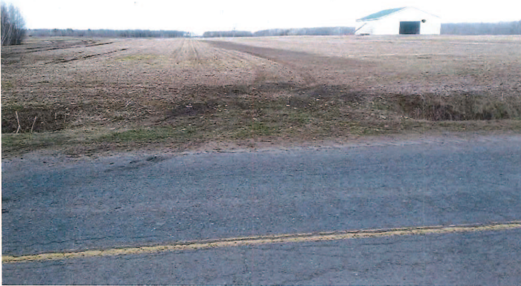
416.jpg Ponceau du fossé du rang
