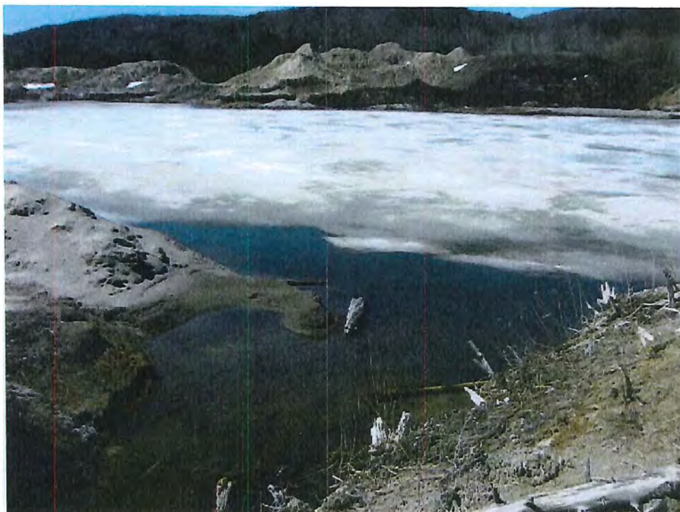
IMG_5328.jpg Un fossé de drainage a été aménagé pour drainer les eaux souterraines (extraction sous la nappe phréatique). L'inspection n'a pas permis d'observer d'entraînement de sédiment dans un cours d'eau:
