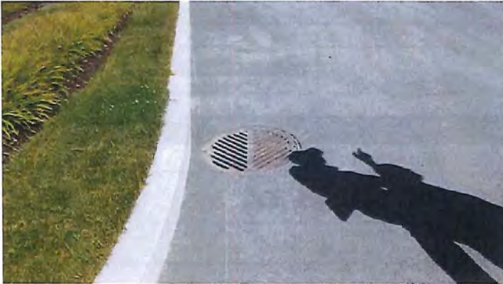
DSCN2207.jpg Vue des puisards.
