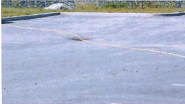
DSCN2214.jpg Vue des puisards.
