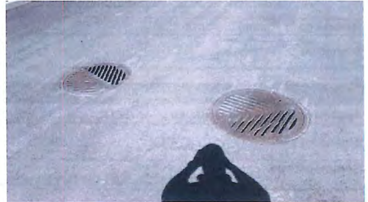
DSCN2212.jpg Vue des puisards.
