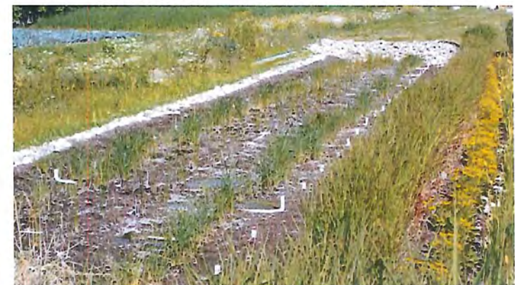
DSCN2200.jpg Vue du marais artificiel de traitement.
