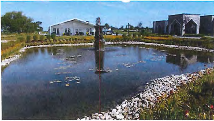
DSCN2201.jpg Vue du 1 er bassin de rétention.
