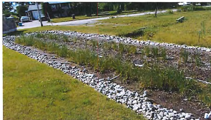
DSCN2199.jpg Vue du marais artificiel de traitement.
