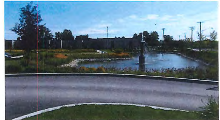
DSCN2217.jpg Vue du 2 e bassin de rétention.
