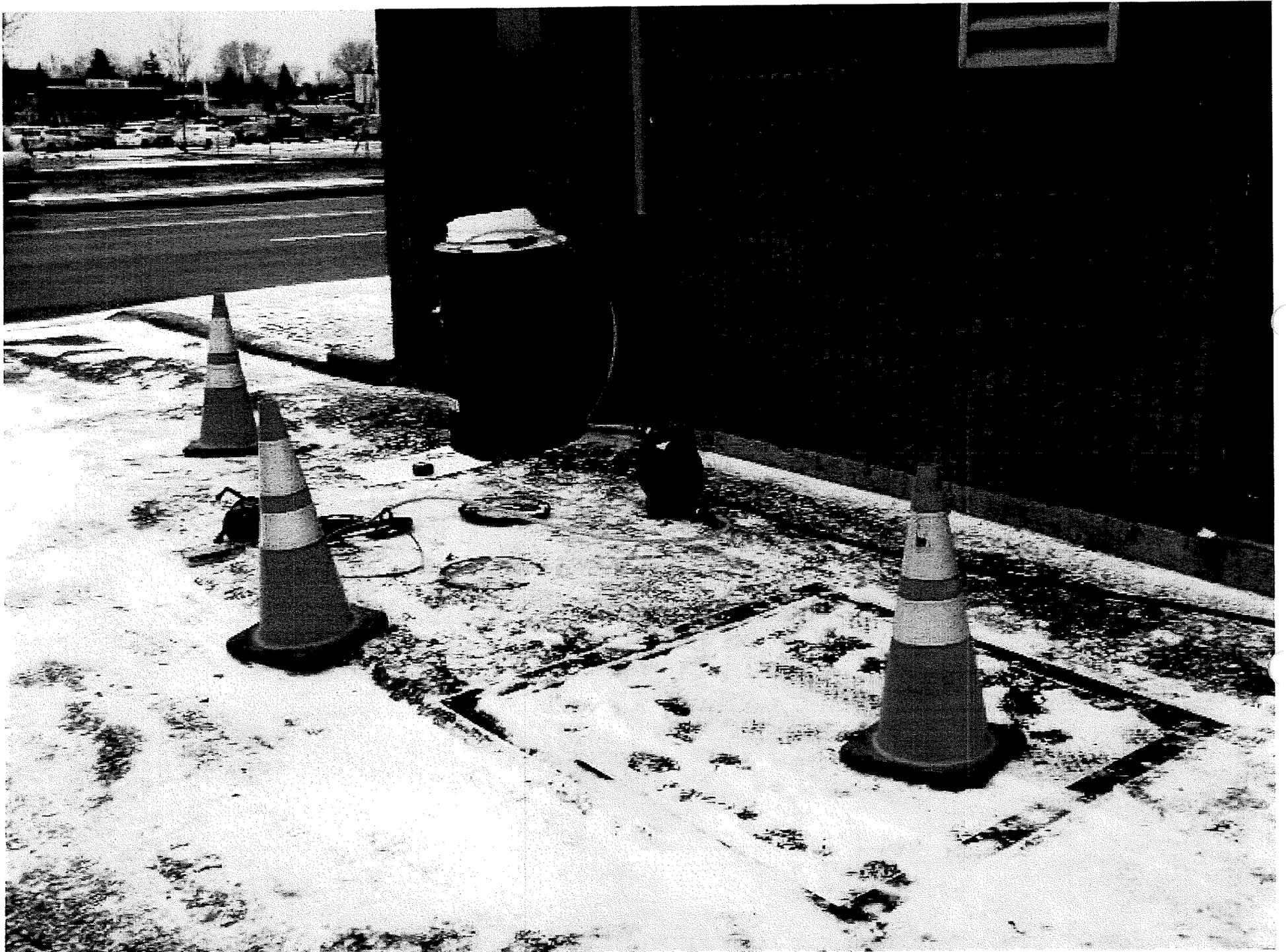
**Photo 1. Dalle de béton de ciment où se situent le trou d'homme, le port de soutirage et le reniflard**
