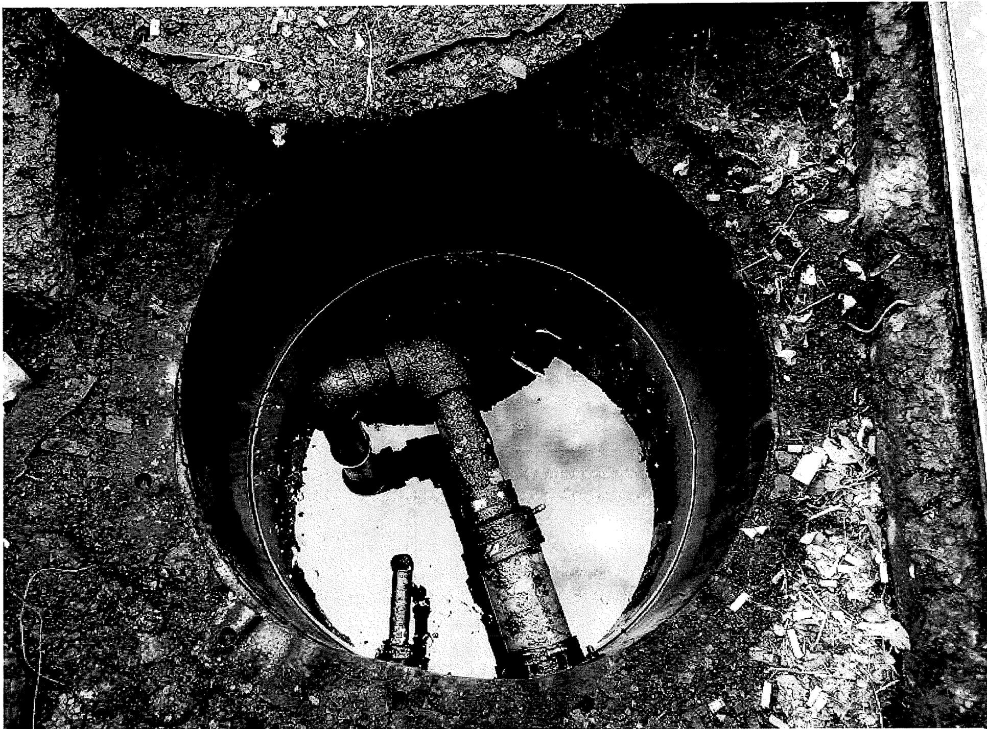
**Photo 3. Intérieur du trou d'homme où la conduite d'huile est raccordée au réservoir souterrain. Une accumulation d'eau et d'huile est notée à l'intérieur du trou d'homme.**
