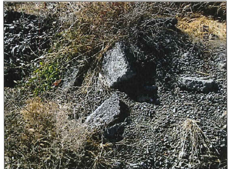
IMG_3519.JPG photo 18 : Morceaux d'asphalte à l'intérieur du remblai.
