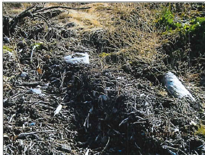
IMG_3524.JPG photo 19 : Copeaux de bois et sacs de plastiques à l'intérieur du remblai.
