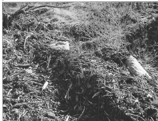
IMG_3524.JPG photo 19 : Copeaux de bois et sacs de plastiques à l'intérieur du remblai.
