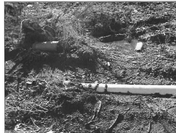
IMG_3526.JPG photo 20 : tuyaux de pvc à l'intérieur du remblai.
