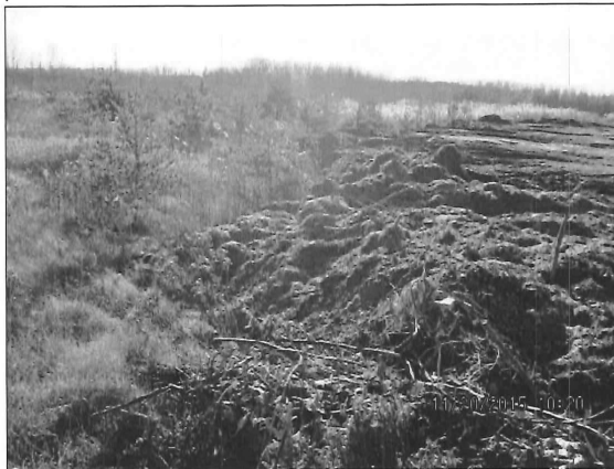
IMG_3514.JPG photo 15 : Remblai fait de feuilles mortes, branches et autres résidus végétales.
