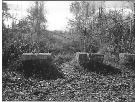
IMG_2794 (Small).jpg 2) Barrière limitant l'accès au fond de la cour du 235, rue Poliquin.
