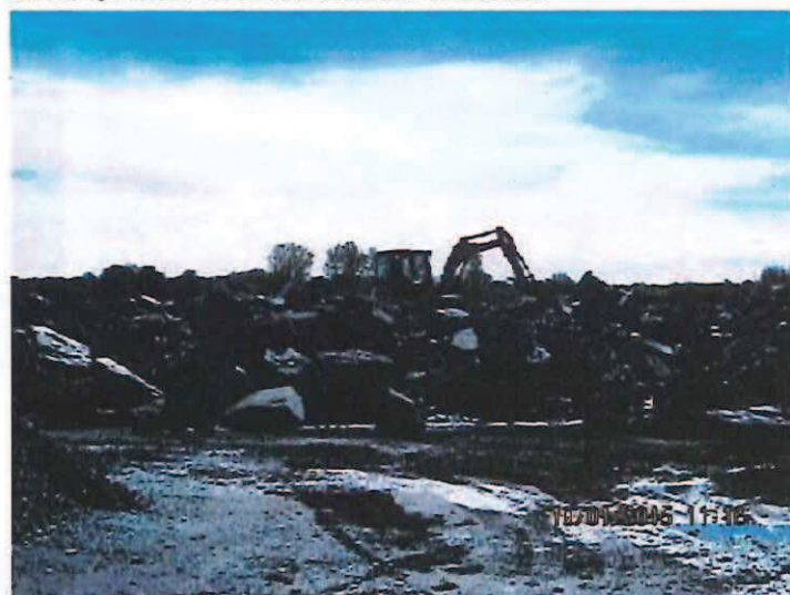
14. IMG_3779.JPG Pelle mécanique en opération
