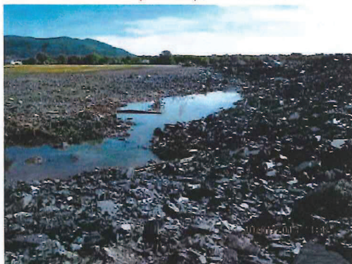
12. IMG_3777.JPG Roche dynamitée recouvrant l'ancienne excavation
