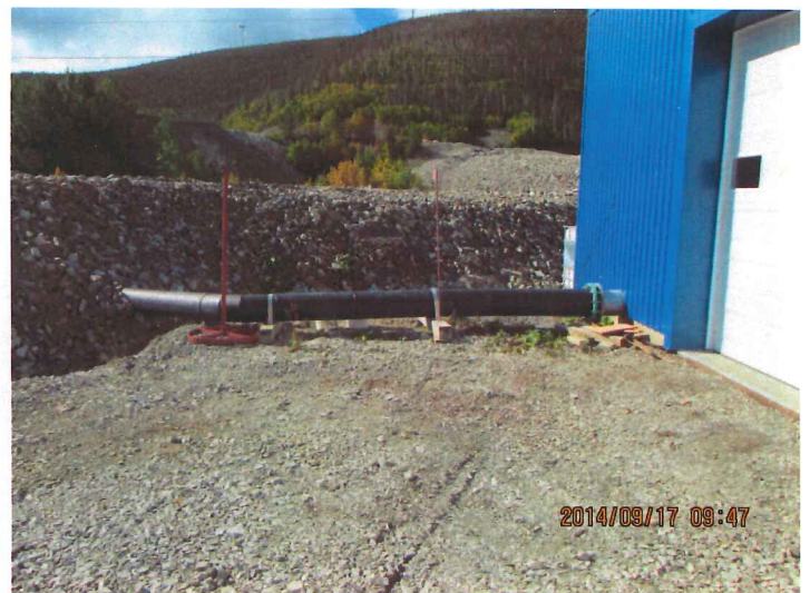
Photo 4. Usine de traitement des eaux
