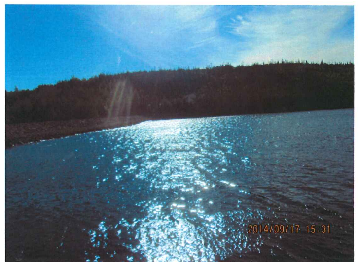
Photo 36. Barrage avec retenue d'eau, effluent final
