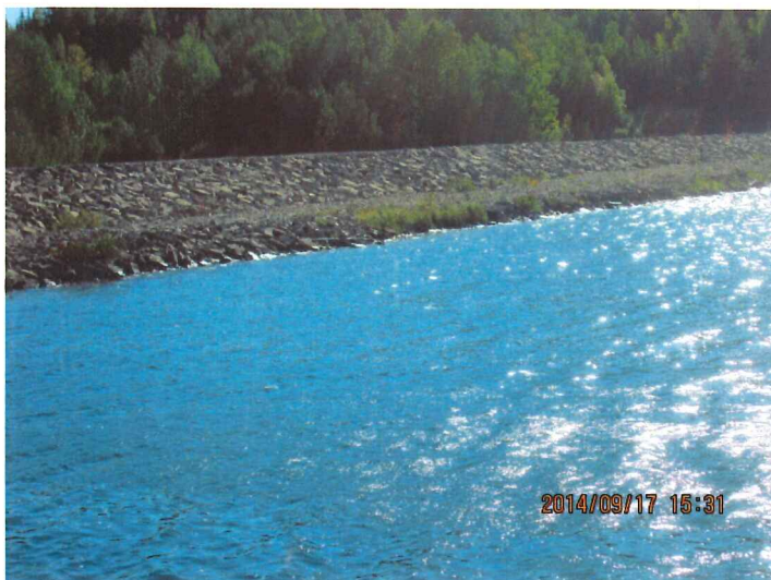
Photo 35. Barrage avec retenue d'eau, effluent final
