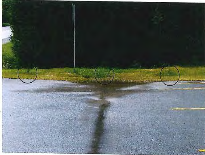
3. Photo prise en 2010 démontrant l'absence de pierres concassées et la présence d'arbres et arbustes récemment plantés (P6010147.JPG).
