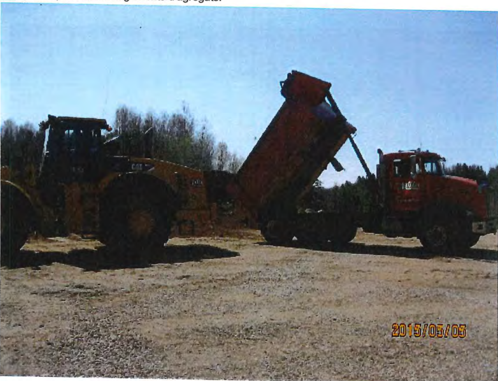
Photo 3. Déchargement d'agrégats provenant de la sablière dans le but de faire du concassage.
