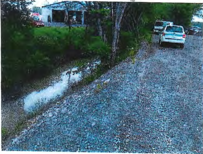
1. Un stationnement est fait en matériel granulaire dans la rive du cours d'eau.
