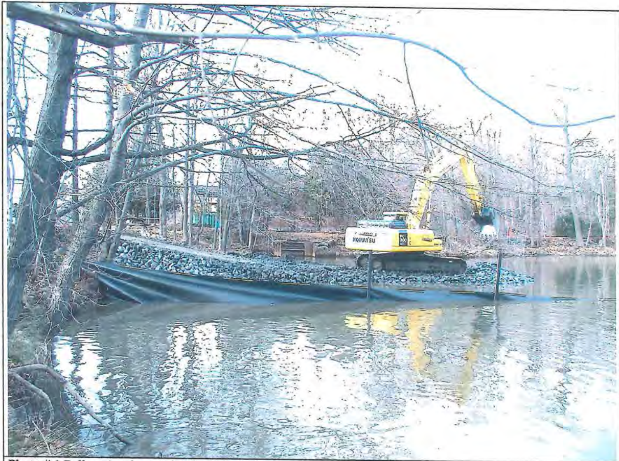
Photo # 1. Pelle mécanique qui retire le batardeau, vue de la membrane de confinement
