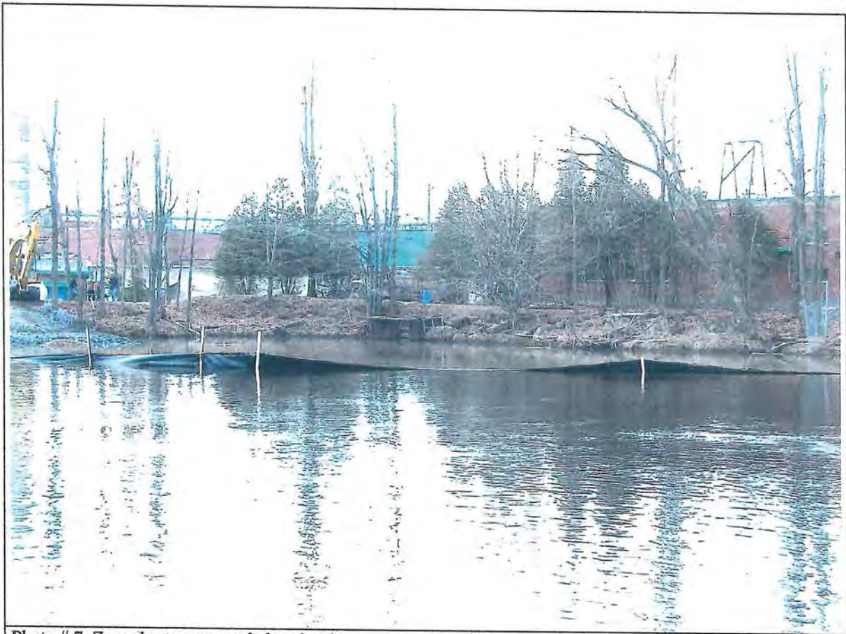
Photo # 7. Zone des travaux et de la prise d'
