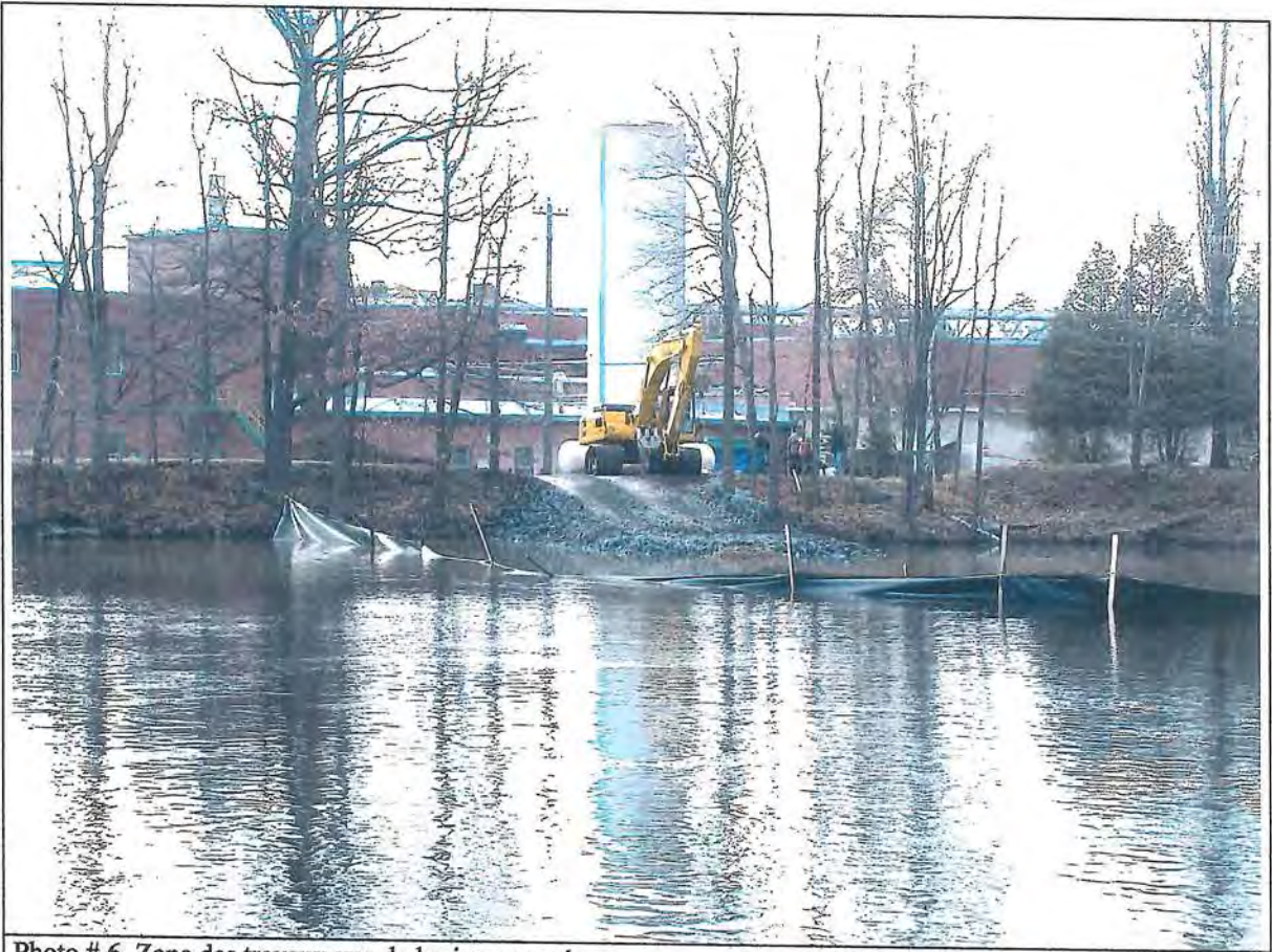
Photo # 6. Zone des travaux vue de la rive opposée
