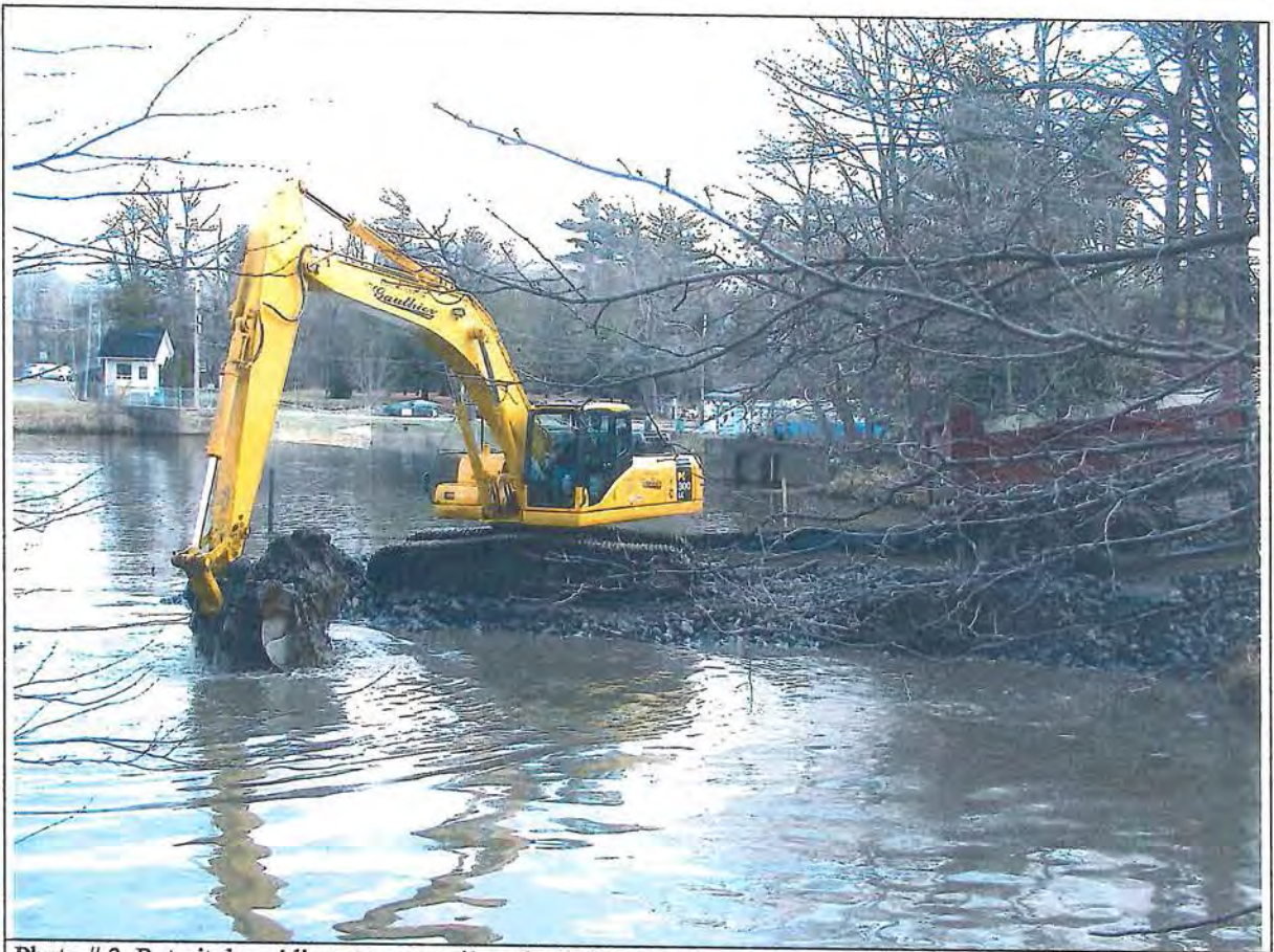
Photo # 3. Retrait des sédiments , en arrière plan le barrage Cascade
