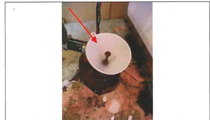
DSC04052 (Small).JPG Photo 10. Entonnoir sur tête de puits
