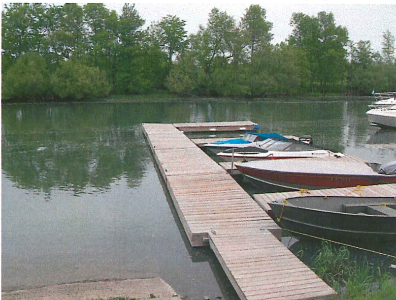
Photo 4, 7430-16-01-0364300 DSCN8962 : Vue de la passerelle et des quatre (4) sections du quai B et de la rampe de mise à l'eau.
