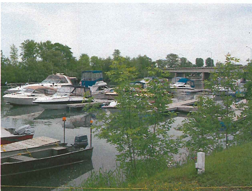
Photo 5, 7430-16-01-0364300 DSCN8963 : Vue des quais C et D.
