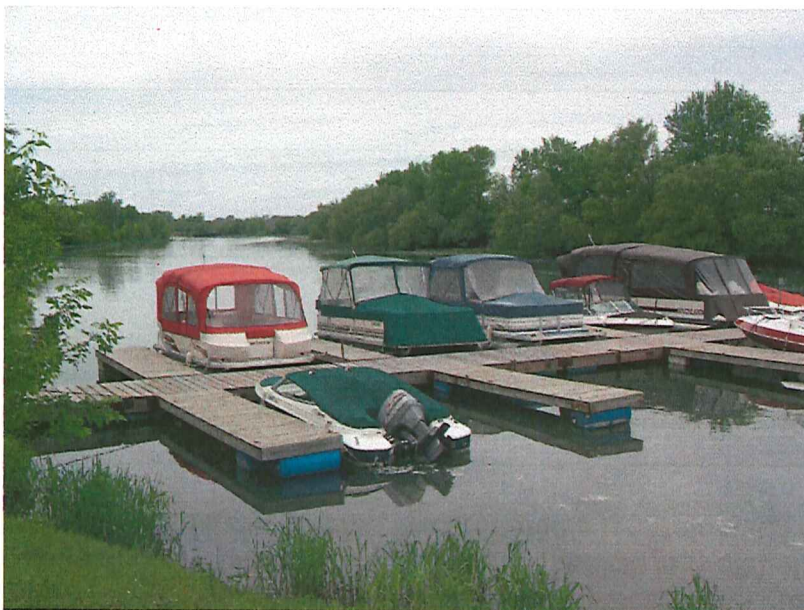
Photo 3, 7430-16-01-0364300 DSCN8961 : Vue du quai flottant A.
