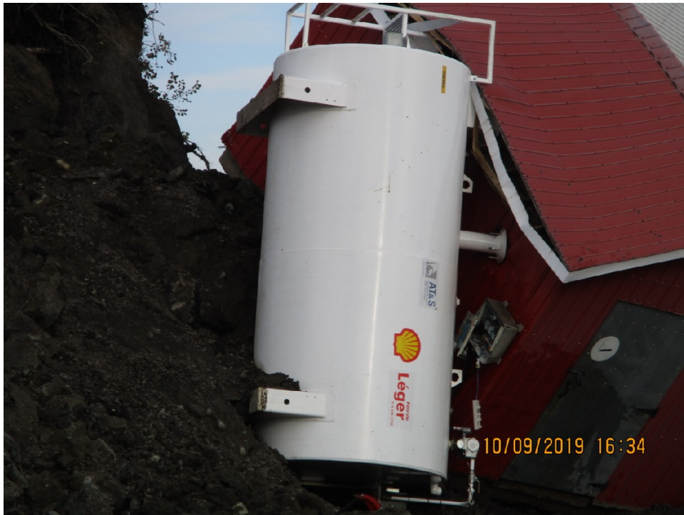
Photo 04; Vue du réservoir de diesel dans les hauteurs, suite au soulèvement de terrain
