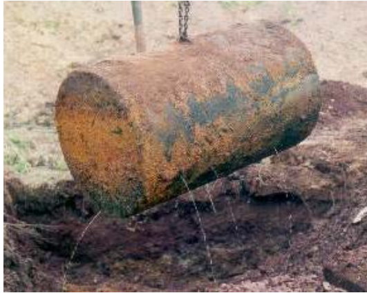
Excavation d'un vieux réservoir enfoui
