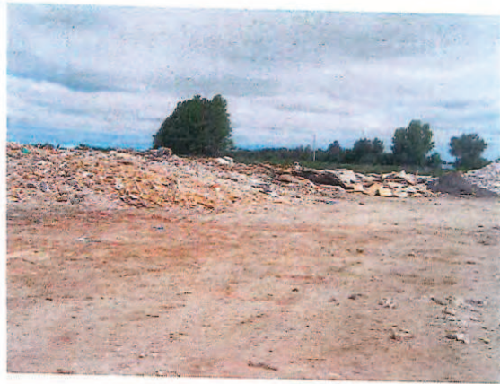
IMG_3893.JPG Matières sur le site
