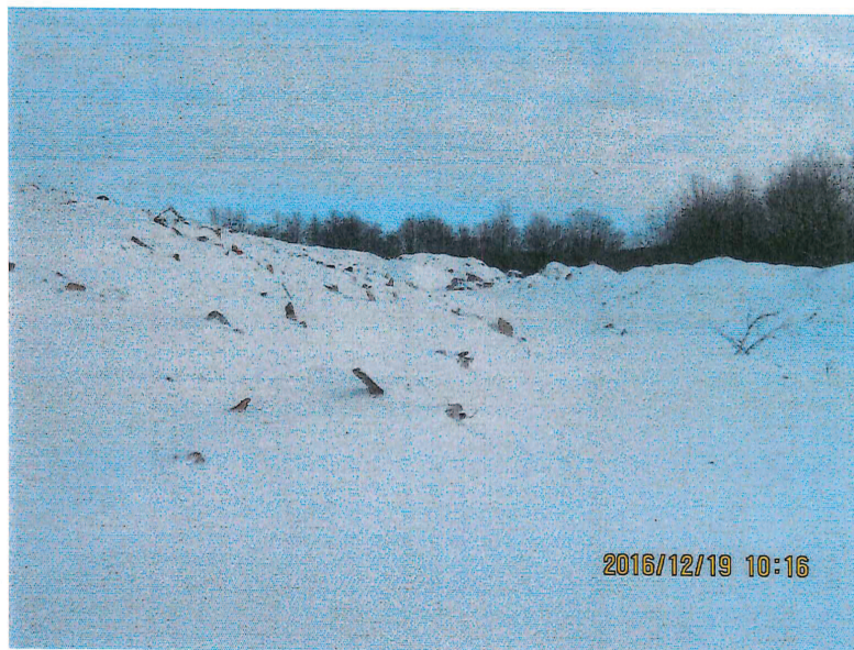
IMG_4131.JPG Amas de débris de construction et de démolition entreposés à l'extérieur de l'aire autorisée.
