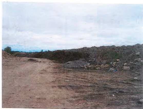
IMG_3897.JPG Berme antibruit en construction
