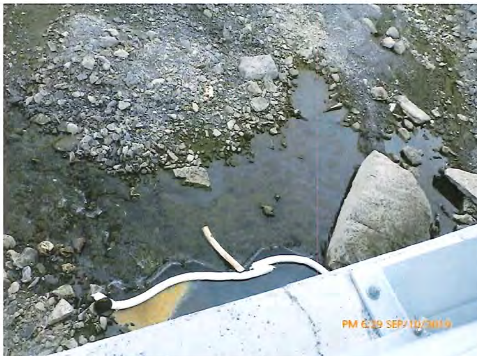
Photo 12. Boudin absorbant positionné à l'embouchure du ruisseau d'Ardoise par le SI de St-Georges
