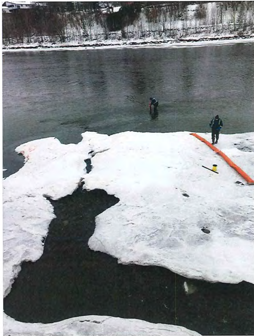
Photo 17: Installation des estacades par Véolia (2019-11-21)
