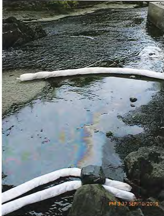
Photo 7. Hydrocarbure qui coule dans le ruisseau d'Ardoise malgré la pose de boudin
