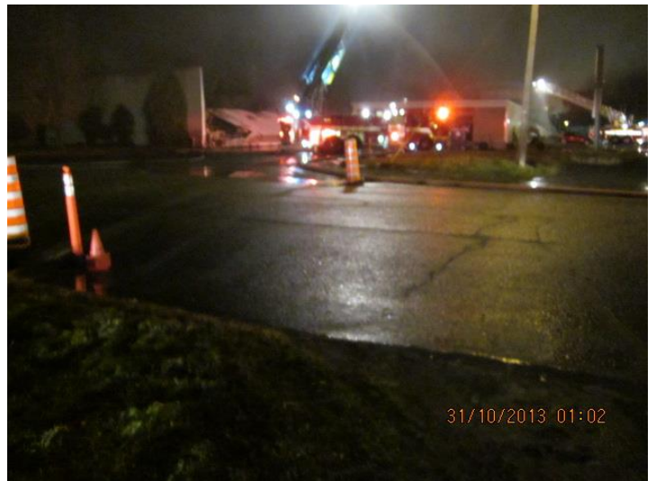
Photo4 : IMG_1722.jpg : Eaux évacuées
