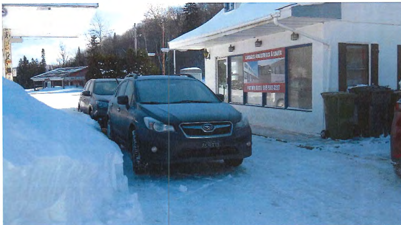
Photo 2 : Bâtiment de service.
