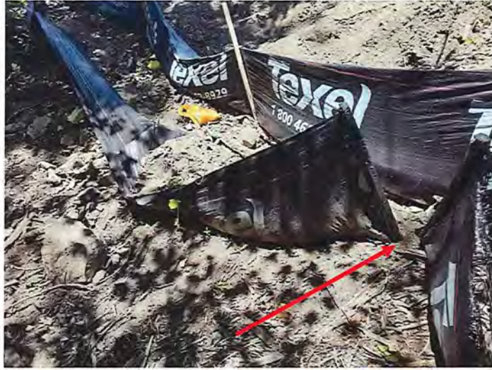
Photo 13. Barrière à sédiments laissant s'échapper sable et gravier (Orientation : Nord-Ouest)
