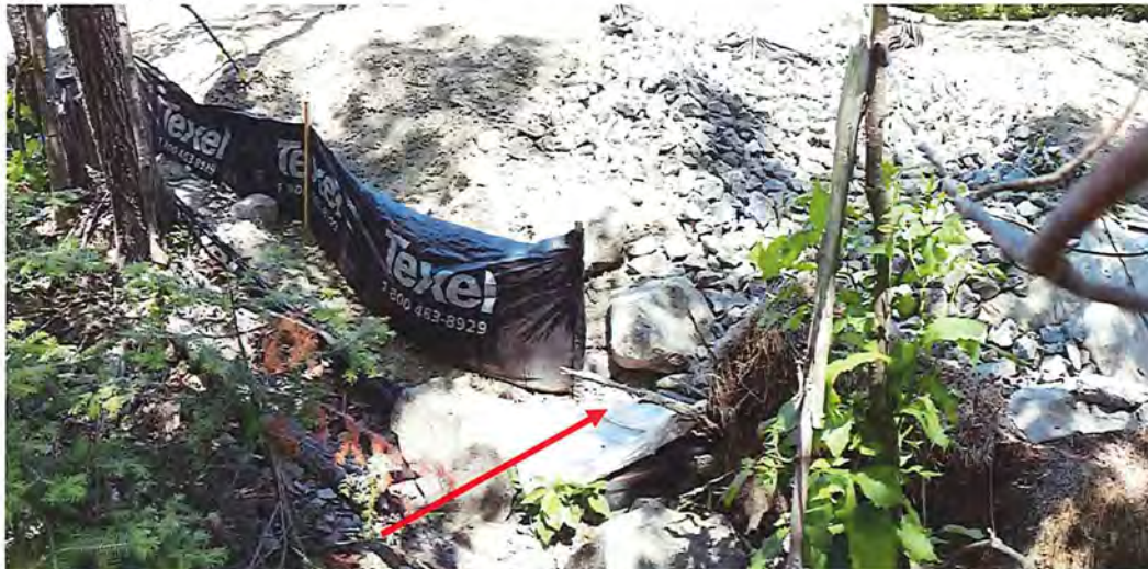
Photo 7. Brèche dans la barrière à sédiments (Orientation : Nord-Ouest)
