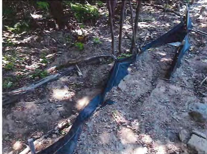
Photo 6. Sable et gravier présents en amont et en aval de la barrière à sédiments (Orientation : Ouest)
