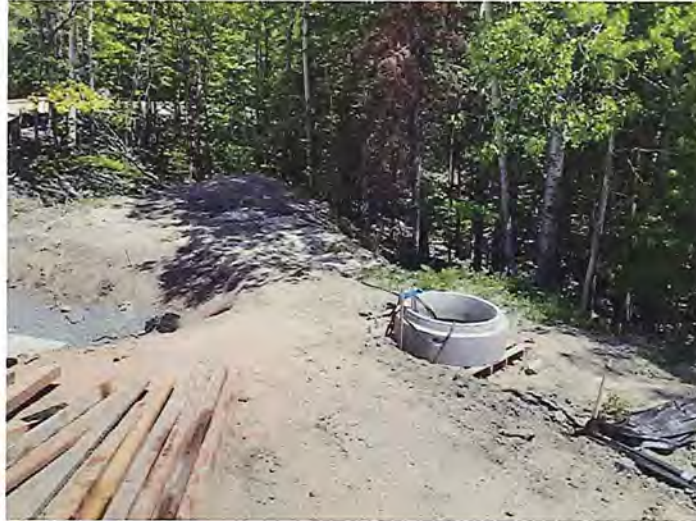
Photo 25. Portion du chantier dépourvue d'une barrière à sédiments (Orientation : Est)
