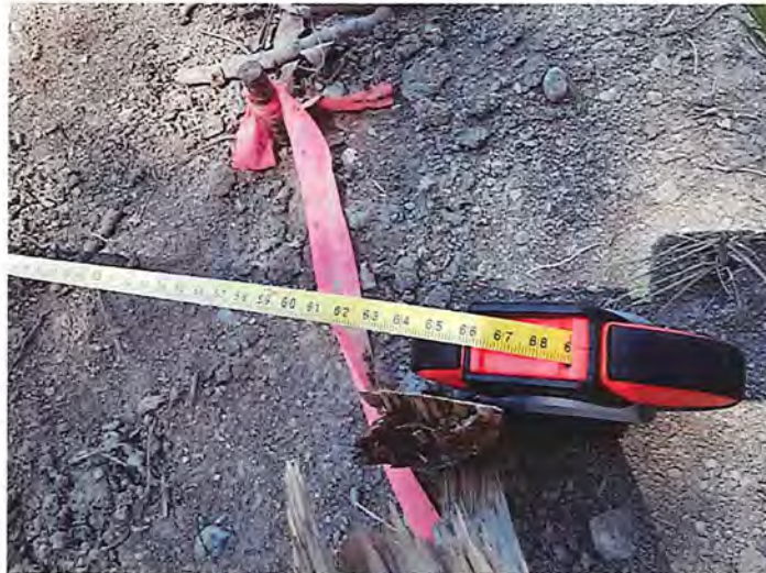
Photo 26. Mesure de la portion du chantier dépourvue d'une barrière à sédiments (Orientation : Ouest)
