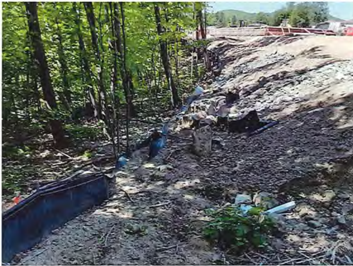
Photo 2. Barrière à sédiments en aval du bassin de sédimentation (Orientation : Ouest)
