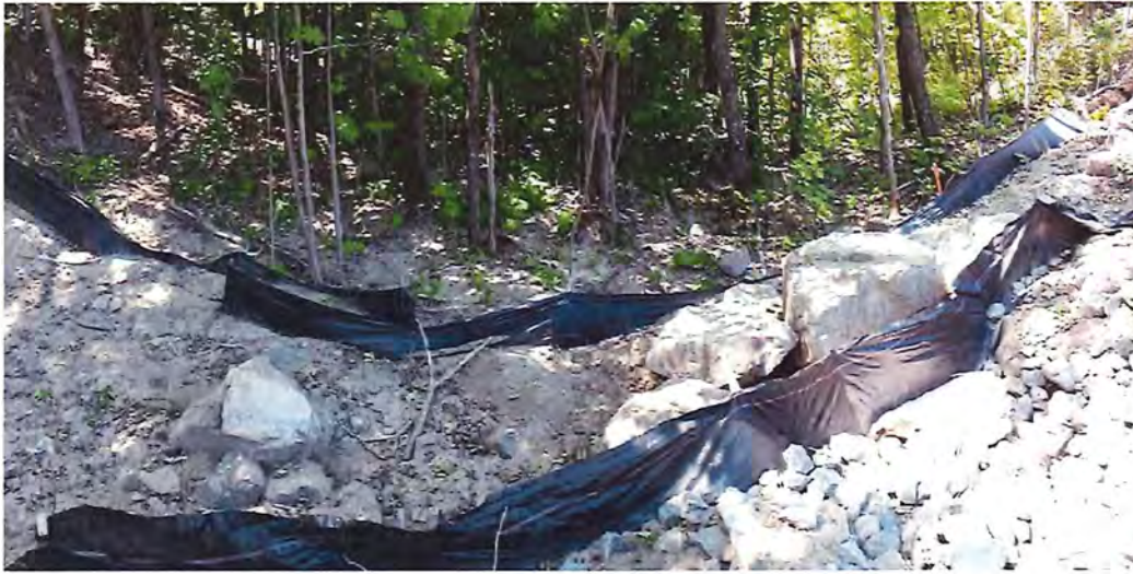
Photo 5. Sédiments présents en amont de la barrière à sédiments (Orientation : Sud)
