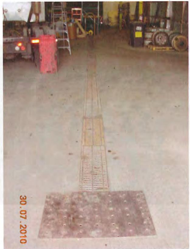
Drain de plancher relié à un séparateur eau/huile indépendant du réservoir souterrain.
