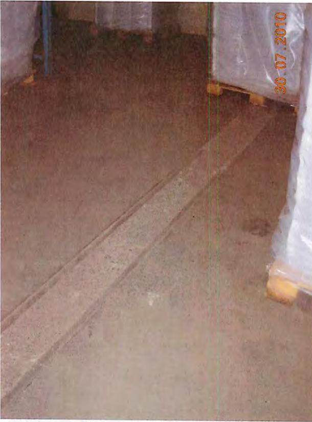
Ancien drain de plancher qui fut nettoyé, vidé et condamné avec du béton.
