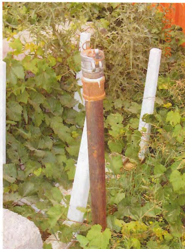
Tuyau d'acier servant à la vidange du réservoir souterrain. Présence de corrosion.
