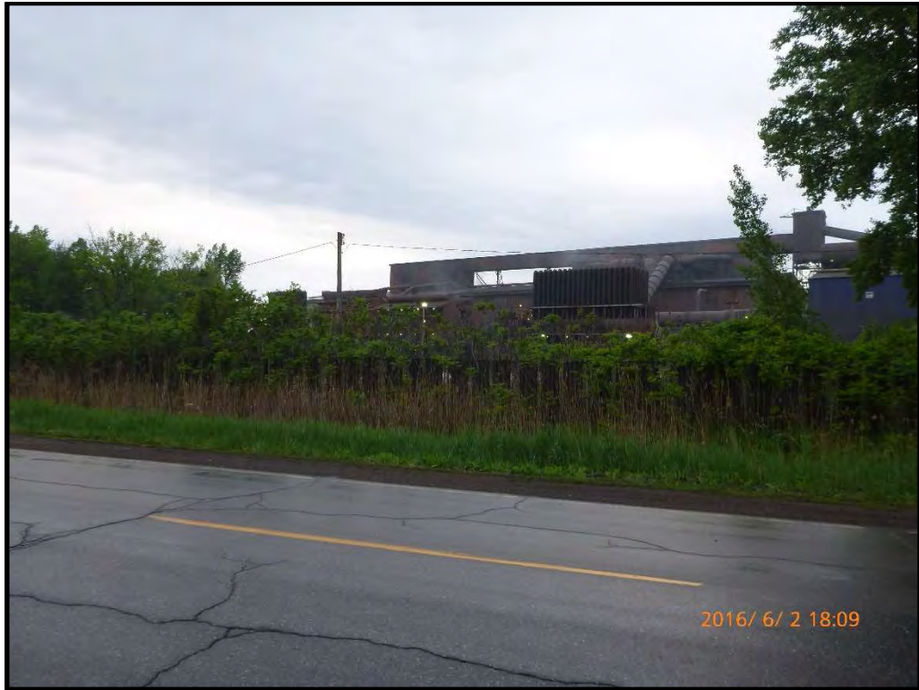
Photographie 21 : Poussières au-dessus de l'aciérie, après la pluie.
