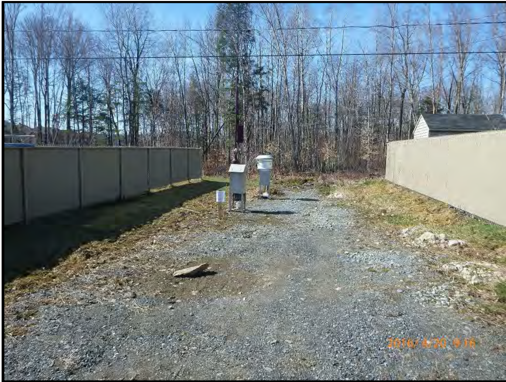
Photographie 7 : Station 4, à côté du 1412, rue Thomas-Valiquet.
