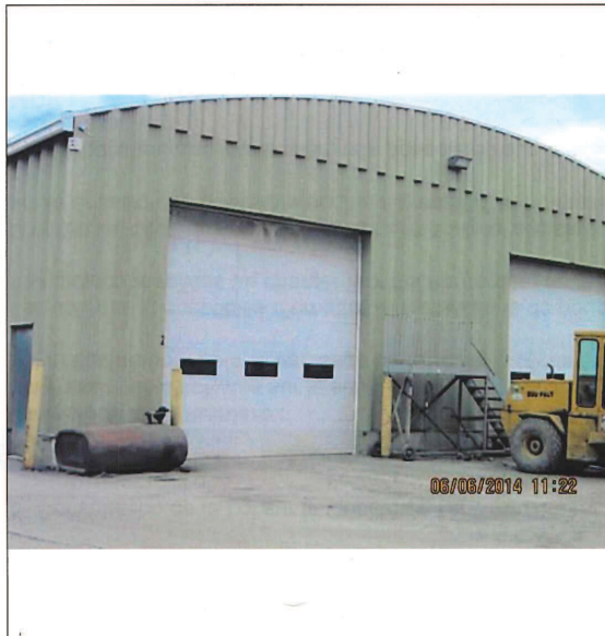
IMG_0257 (Small).jpg Garage de l'intérieur de la cour, avec entreposage d'huile usée à l'extérieur.
