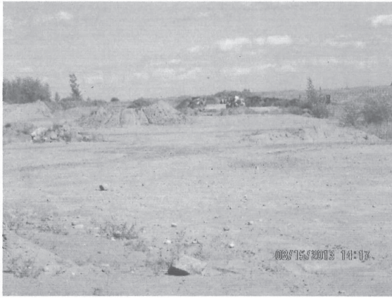
Photo 003.jpg Machinerie en activité vers l'est
